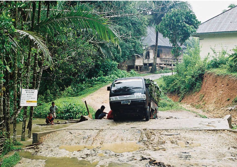
Ada kecenderungan masyarakat untuk mengajukan usulan pembangunan yang bersifat fisik karena memang kondisi infrastruktur desa yang masih buruk
