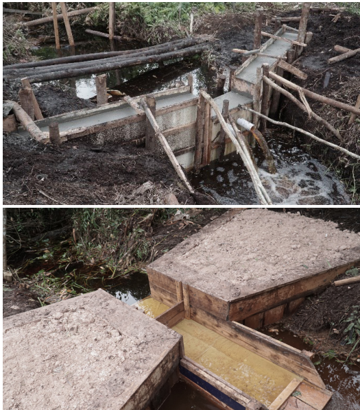
Gambar 12.4 Foto sekam kanal permanen dan non-permanen di lokasi plot percontohan
