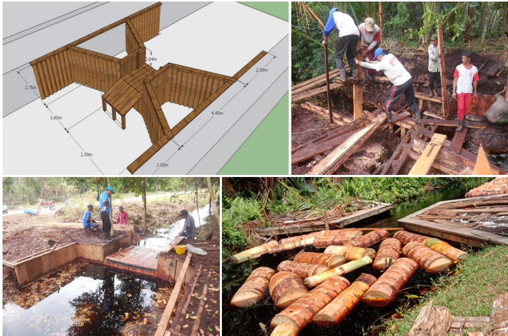
Gambar 9.3 Hasil desain sekat kanal partisipatif disertai spillway dan pintu air (kiri-atas), proses implementasi desain sekat kanal (kanan-atas, dan kiri-bawah), dan proses transportasi tual sagu melewati sekat kanal (kanan-bawah).
