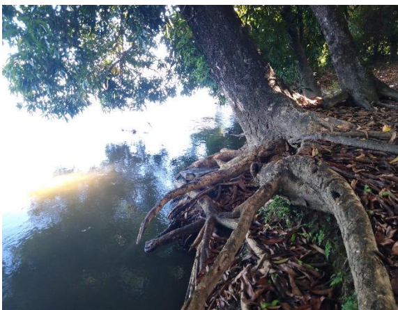
Figure 21: Manguier à risque d'un déchaussement sur la berge du fleuve
